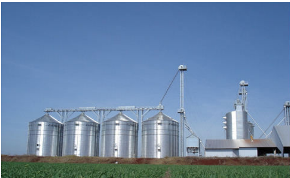
Figura 1: Unidade armazenadora com conjunto de silos metálicos, transportadores e secadores de torre.
