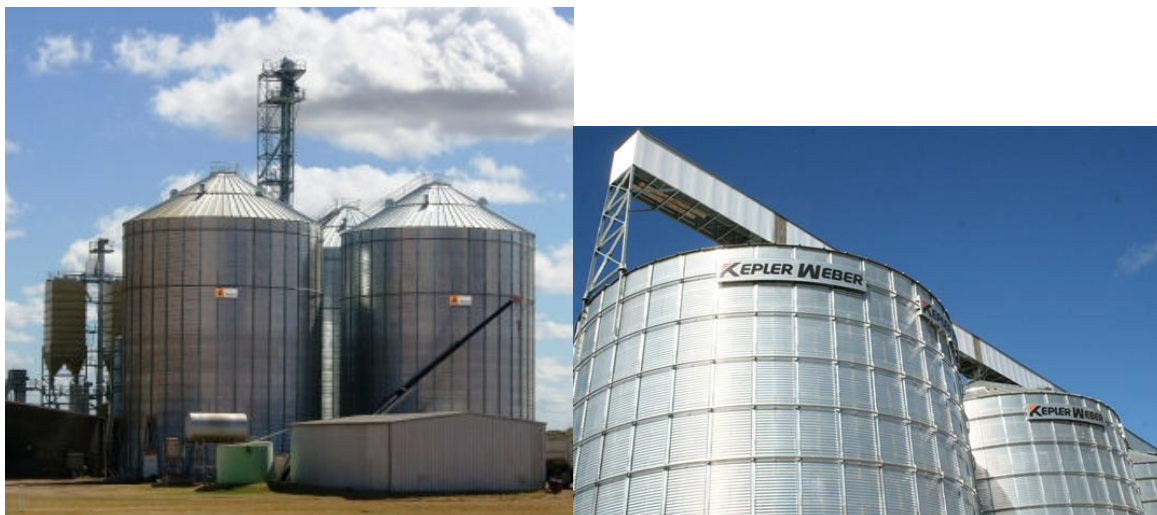
Figuras 2 e 3: Unidade de silos verticais, modelos de chapa metálica. Fonte: própria e Kepler Weber (2013), respectivamente.
